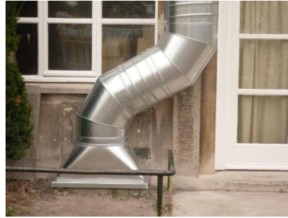
Exemple de conduit inox pouvant être mis en place
